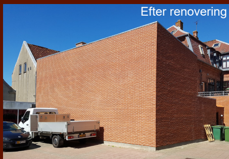
Svirrebom i Lemvig. Eksisterende mur nedtaget og nyt fundament og skalmur er etableret.
