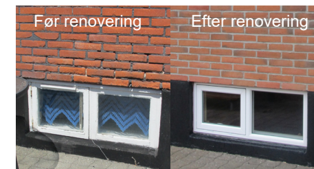
Thyborøn. Eksempel på før og efter reovering af murværk og vinduer.
